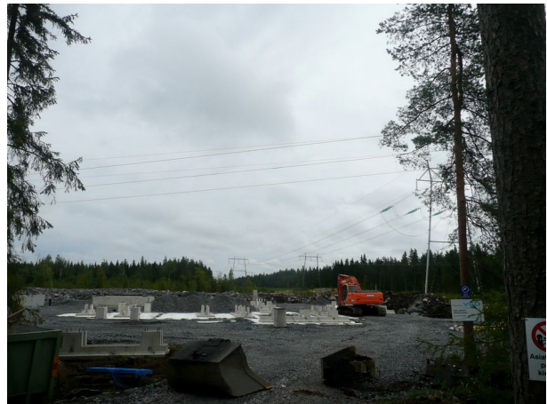
Kuva 18. Merijärven uuden sähköaseman rakennustyömaa liittymiskohtaan lounaispuolella.
