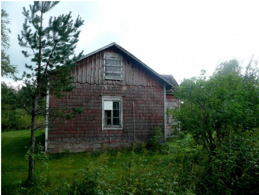
Asuinrakennus kuvattu lounaaseen.
