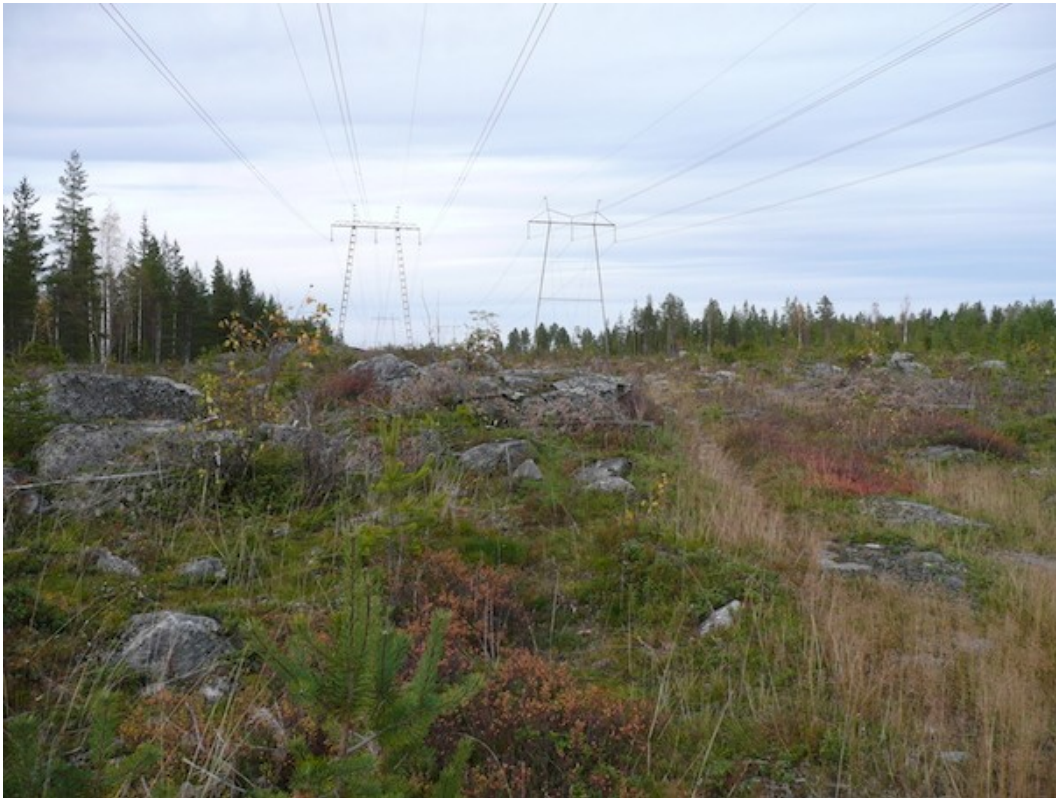
Kuva 13. Kuvattu maakaapelin reitti voimalinjan alla. Kuvattu koilliseen metsäautotieltä. Maasto on hyvin kivinen ja kallioinen.
