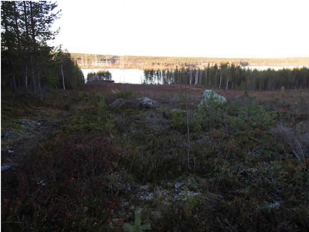
Kuva 15. Maakaapelin linjaus voimalinjan alla. Taustalla Kemijoki. Kuvattu pohjoiseen. Maasto on kivistä.
