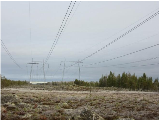
Kuva 44. Voimajohto Katajajärvennevan lounaispuolella. Kuvattu lounaaseen.
