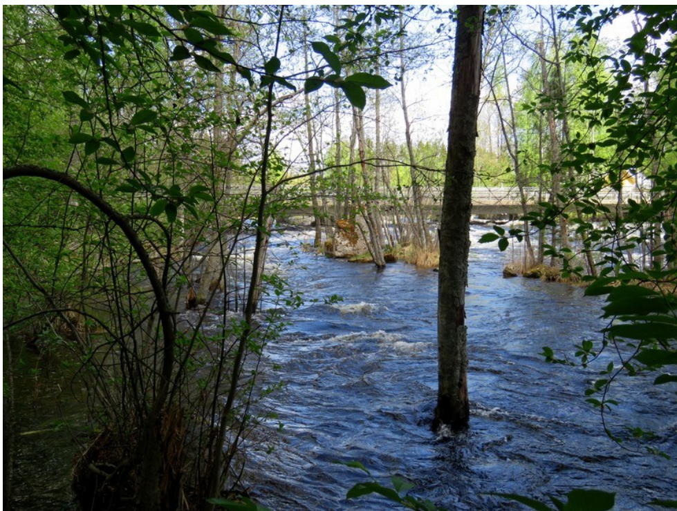
Kohde 1 B Myllyn perustus (kuvassa sillan alapuolella) kuvattu koilliseen.
