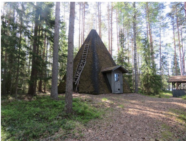
Kuva 1. Haapakanta, kota lähellä rantaa; pääosin pinnaltaan huuhtoutunutta, kivikkoa, rannat soistuneet, paikoitellen vanhaa puustoa.
