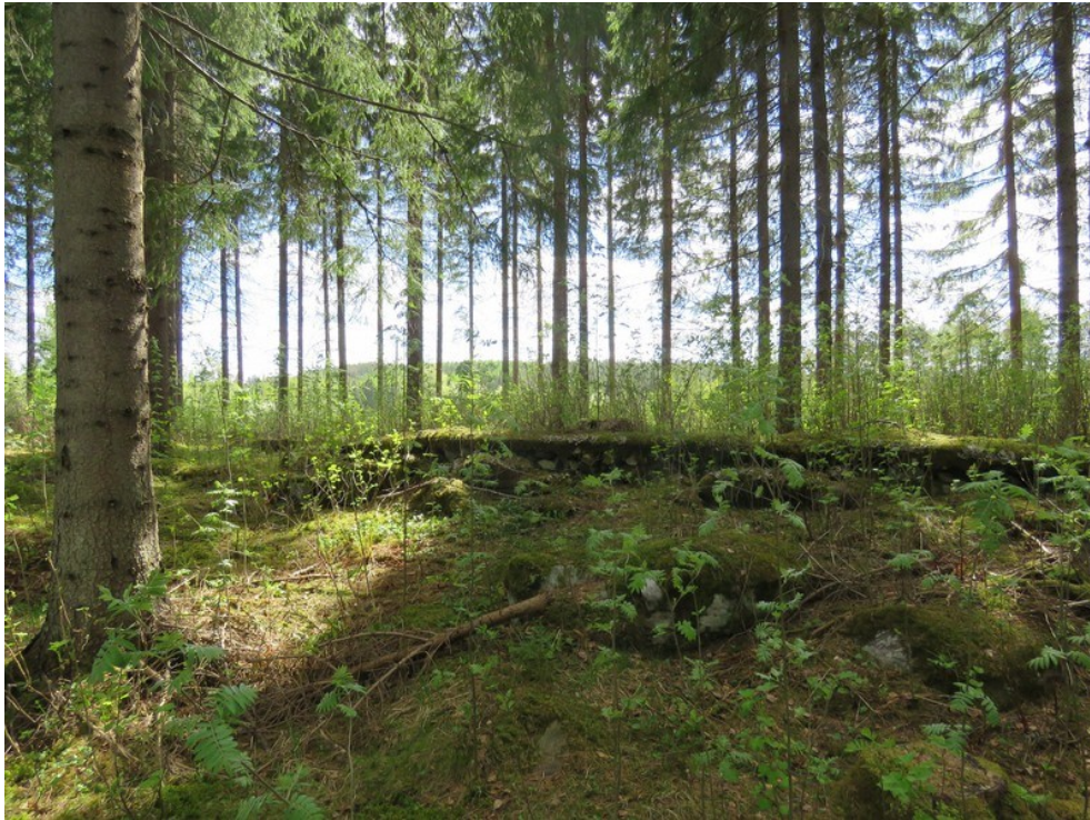
Kohde 2 A. Betonilla valettu perustus kuvattu etelään.
