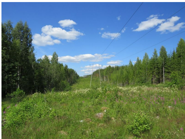
4. Linjausta Tietävälän luoteispuolella, luoteeseen.
