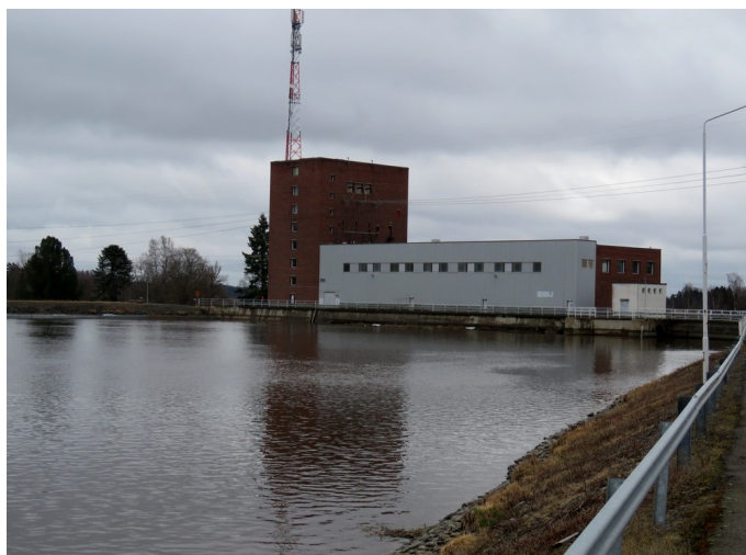
15. Kolsin voimalaitos etelään.
