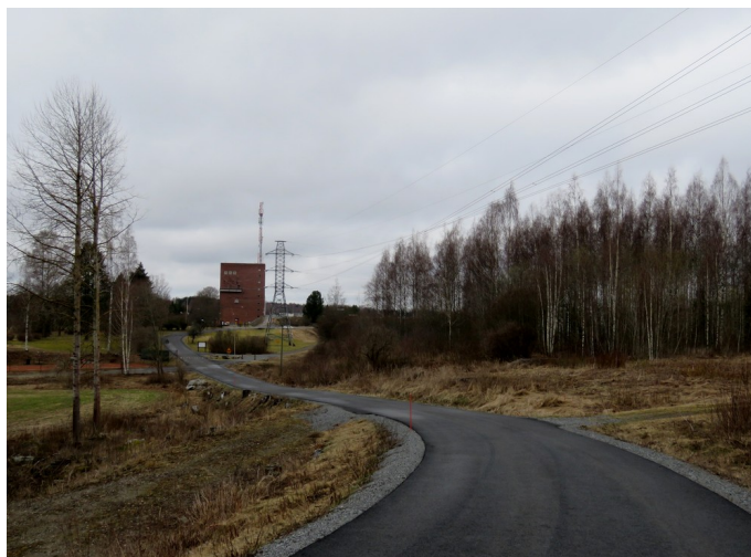
14. Kolsin voimalaitos länteen.
