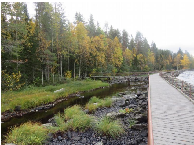
Lankutettua pohjoispäästä etelään. Vasemmalla uittokanavaa.
