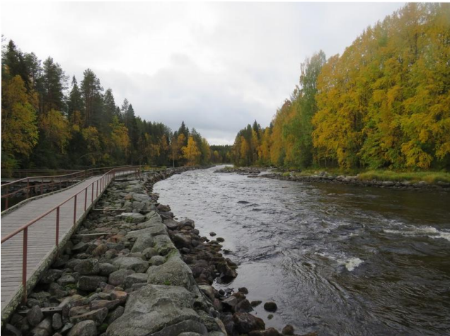
Kosken kunnostettu itärannan möljä, kuva etelään. Länsirannalla erottuu uittokanavaa ja suisteita.
