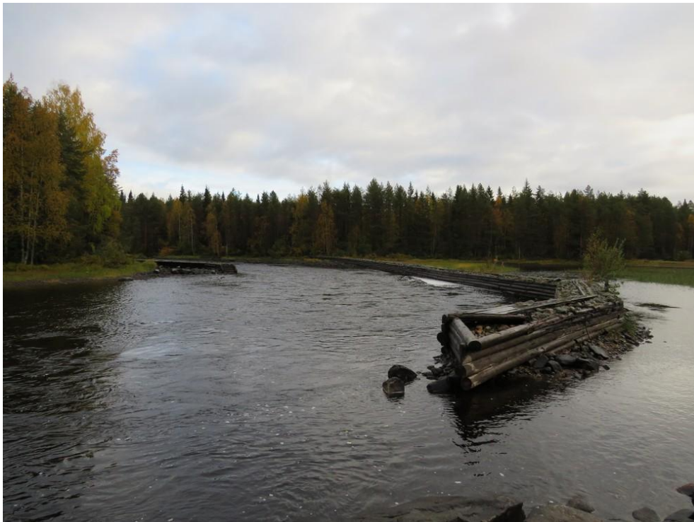
Itärannan möljän eteläpää, kuva koilliseen.
