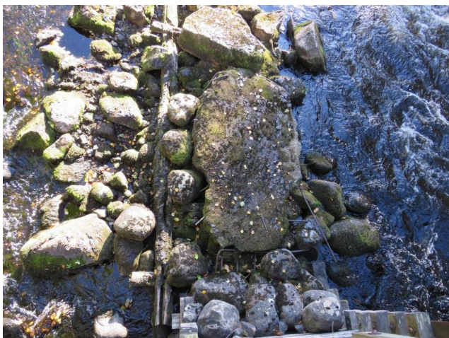
Pohjoisrannan möljiä sillan itäpuolella, ja siinä olevia betonilaattoja.
