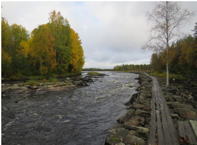
Möljän pohjoisosaa pohjoiseen.
