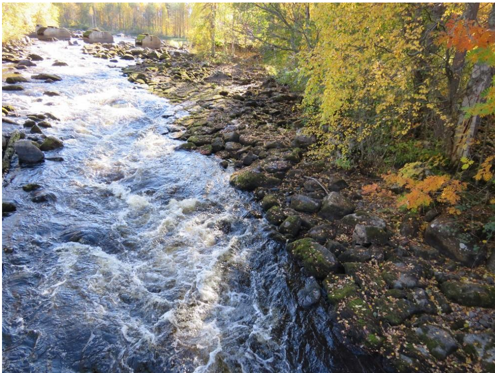
Kaarneenkosken möljä- ja patorakenteita.
