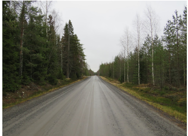
16. Övermarkintietä Lautakankaan kohdalla. Kuva pohjoiseen.
