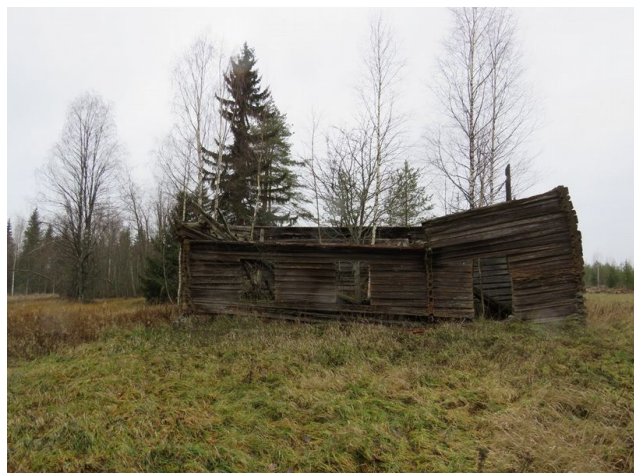
Kuva 39. Rakenne 1, talo pohjoiseen.
