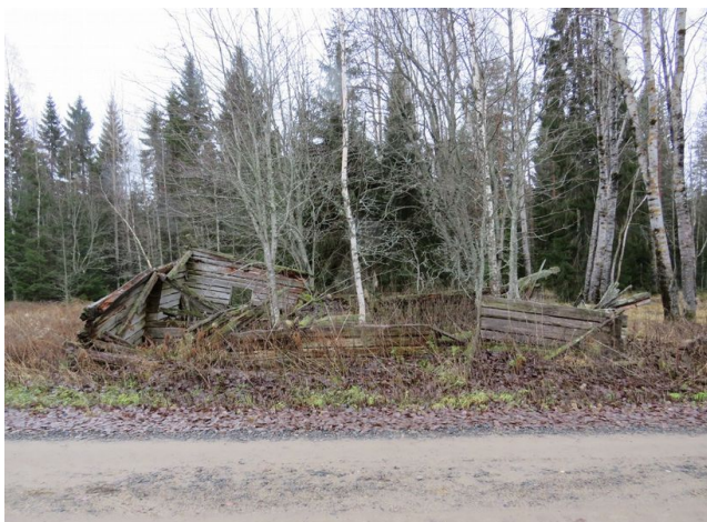
Kuva 40. Rakennus 3, rakennuksen jäännös etelään.
