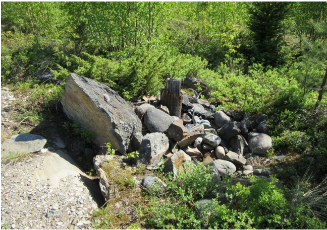
Kuva 17. Entisen sähköpylvään tukikiveys.
