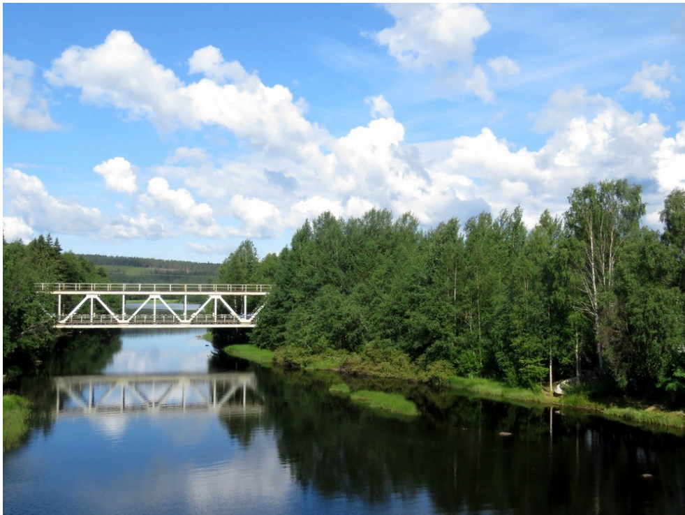
Näkymä tiesillalta länteen rautatiesillalle.
