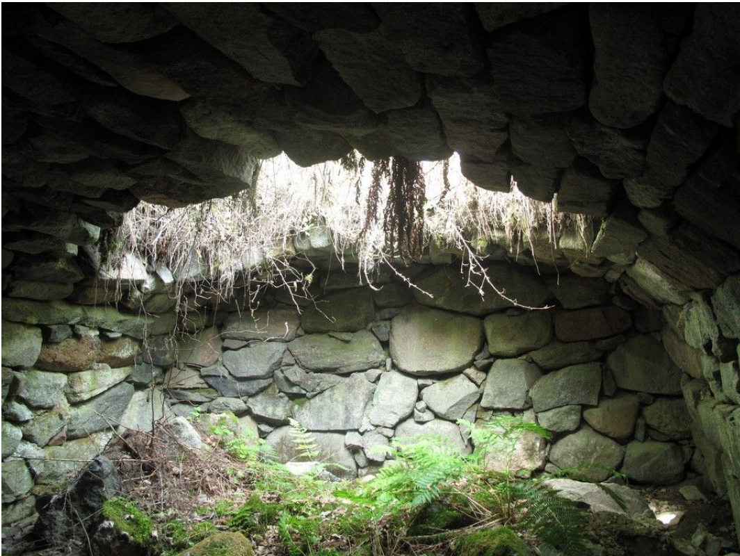
Kuva 14. Koivulan osittain sortunut maakellari. Pohjoiseen.
