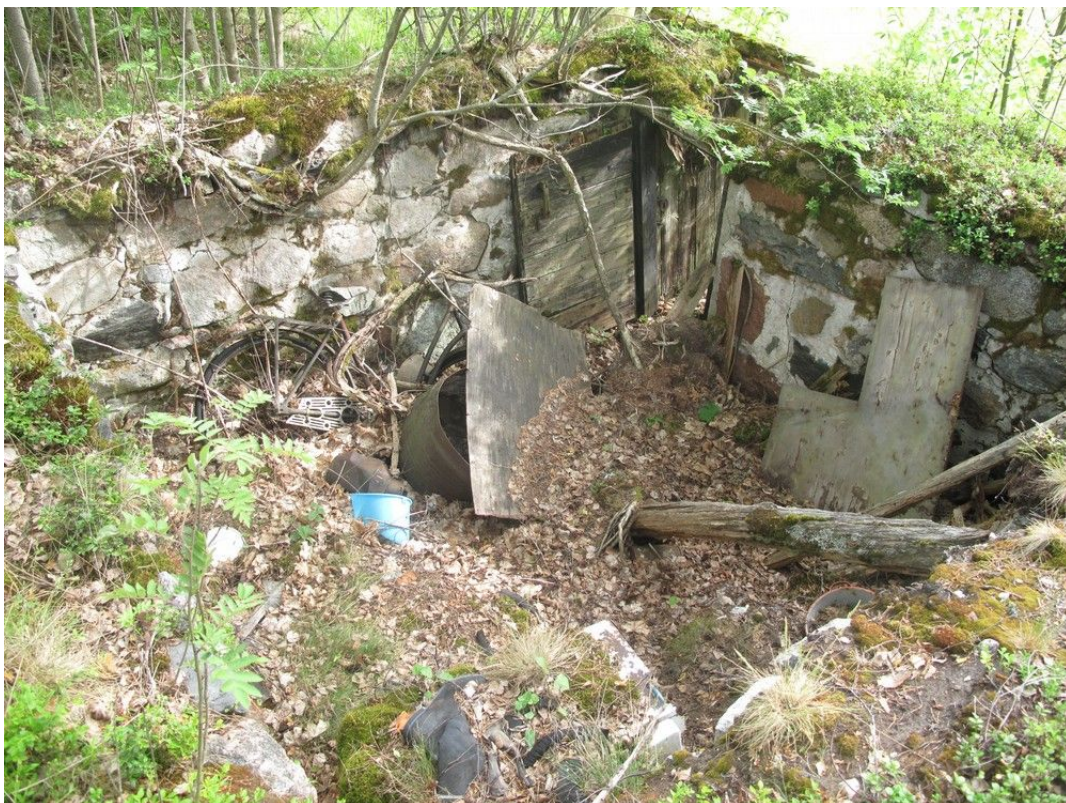
Kuva 15. Vanhan maakellarin jäänteet kohteessa 5. Lounaaseen.
