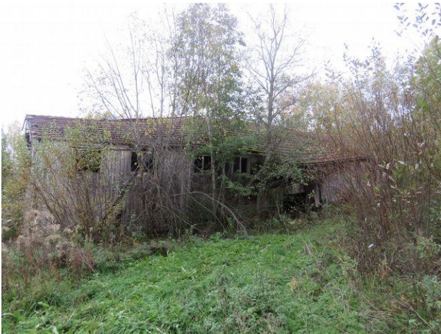
Saha-/myllyrakennus kuvattu luoteeseen.
