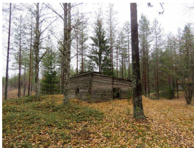
Talli kuvattu koilliseen.
