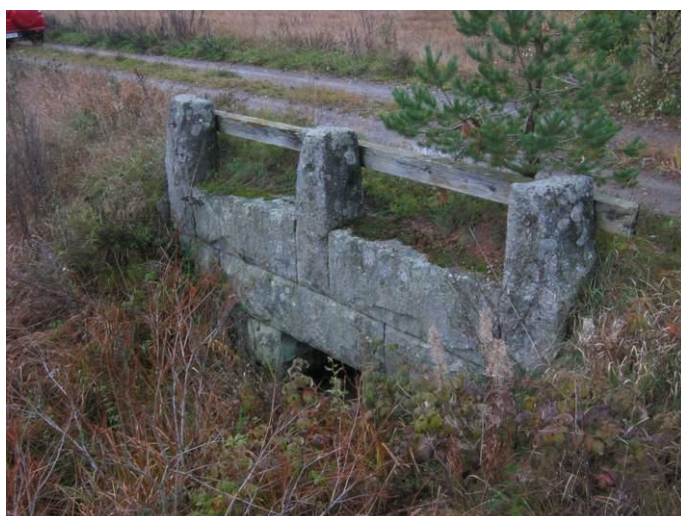
Kuva 19. Naulinsuon vanha 1800-luvun kivisilta on säilynyt hyvässä kunnossa. Länteen.
