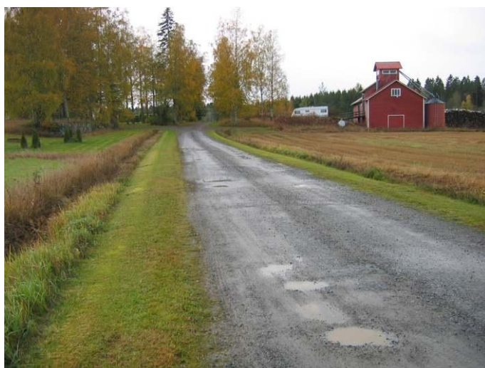
Kuva 15. Vanhan tielinjauksen säilynyttä osaa Kapeakankaantien lounaispuolella, vasemmalla Rossin talon pihapiiriä ja siellä vanhan kavinavetan perustukset. Lounaaseen.
