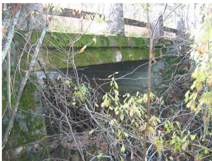
Kuva 16. Kuusjoen ylittävä vanha kivilta on uusittu rakentamalla sen päälle betonilaatta. Etelään.
