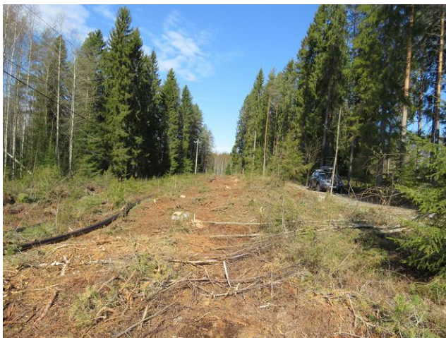
Putkilinjauksen keskiosaa kuvattuna luoteeseen.
