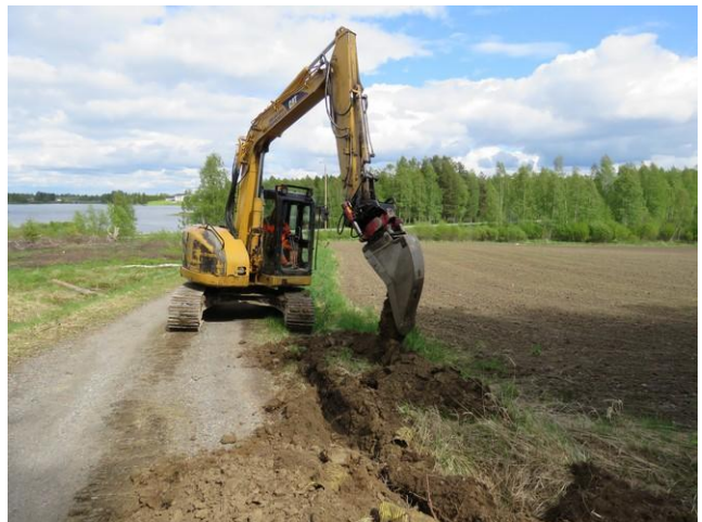
Kuva 10. Kaivantotyö kohdalla - 190 m.
