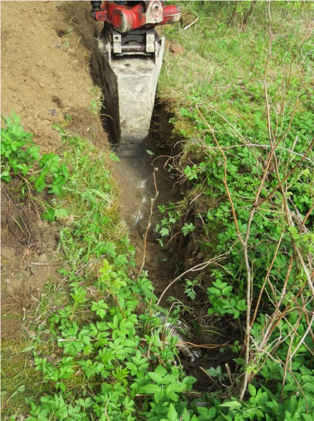
Kuva 3. -10 m. Ohuen humuskerroksen alla oli runsaasti kookkaita kiviä, koneen kauha ei mennyt kivikerroksen läpi.
