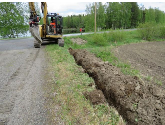
Kuva 13. Kaivutyö on maantien kohdalla.
