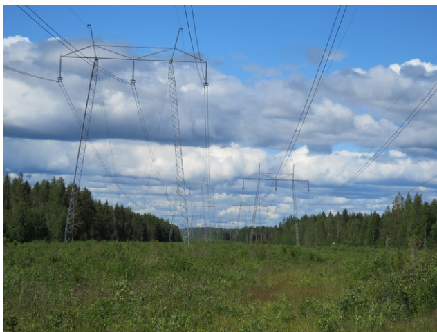
Kuva 62. Voimalinja kuvattu Kotasuolta etelään.
