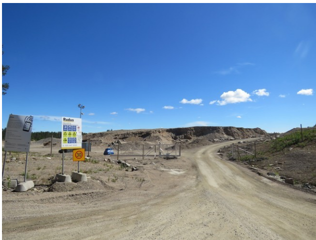
Kuva 57. Keelaharjun laaja sorakuoppa Kontilanperässä, kuvattu etelään.
