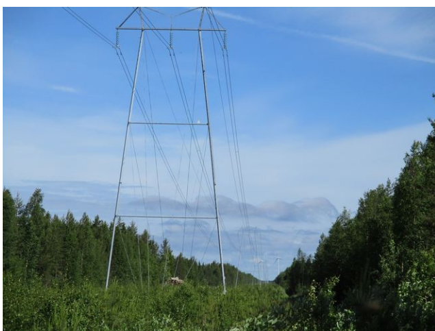
Kuva 18. Läntinen voimalinja Muhojoen kohdalla kuvattu pohjoiseen.
