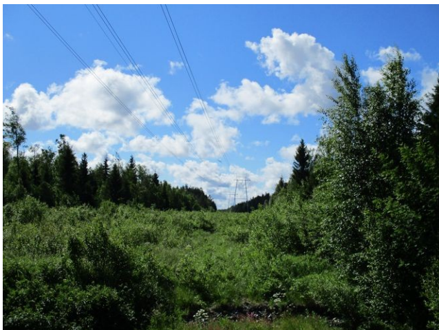
Kuva 7. Läntinen voimalinja kuvattu etelään.
