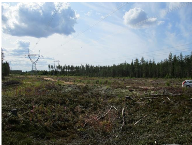
Kuva 21. Voimalinja Houraatinkankaan kohdalla, linjaus kulkee metsätien lounaispuolella.
