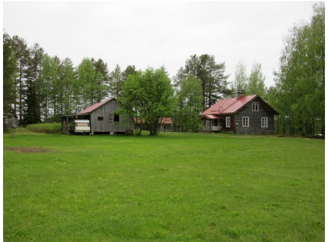
Kuva 8. Lapinniemen talo kuvattu länteen.
