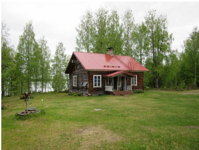
Kuva 9. Lapinniemen talo ja pihakaivo länteen.
