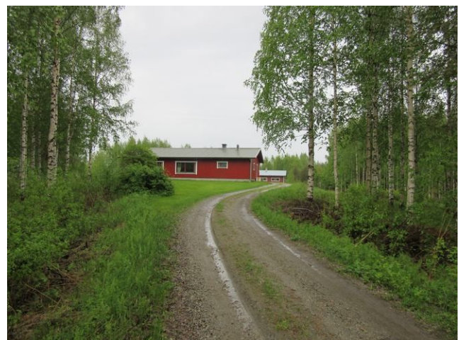
Kuva 12. Pääkkölän talon paikalla on uusi ok-talo.
