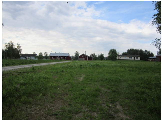
Kuva 32. Luotolan talo. Kuvattu pohjoiseen.
