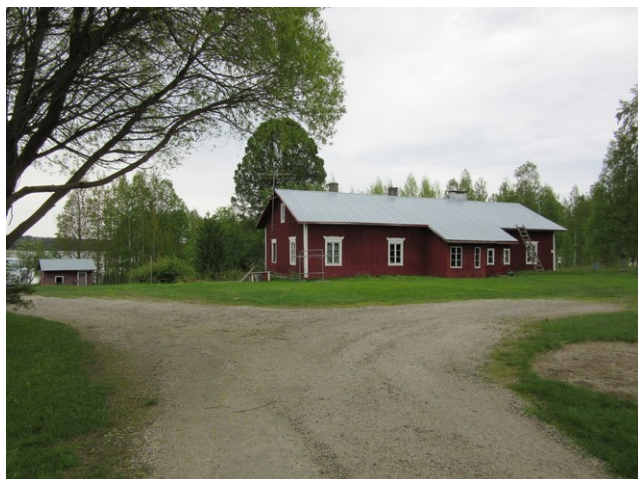
Asuinrakennus kuvattu koilliseen.
