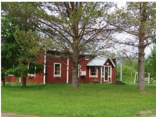
Asuinrakennus kuvattu koilliseen.
