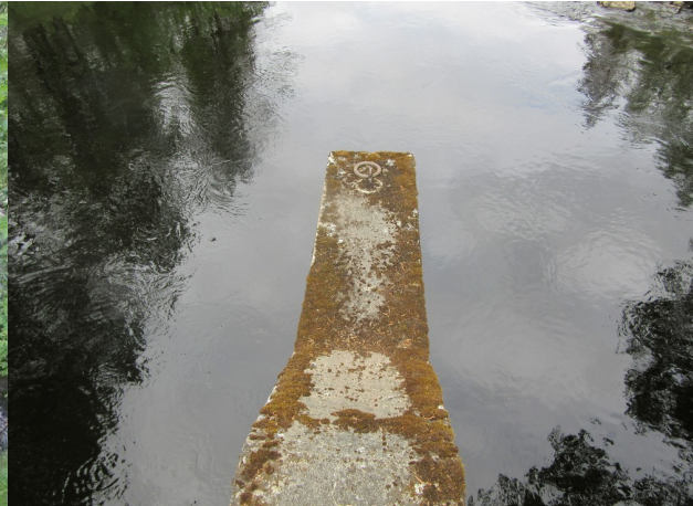
Yksi padon kiinnitysrenkaista.
