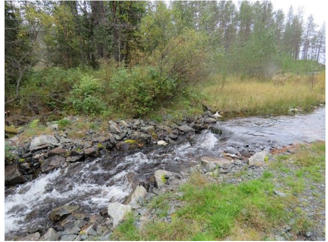
Pohjapato kuvattu lounaaseen..
