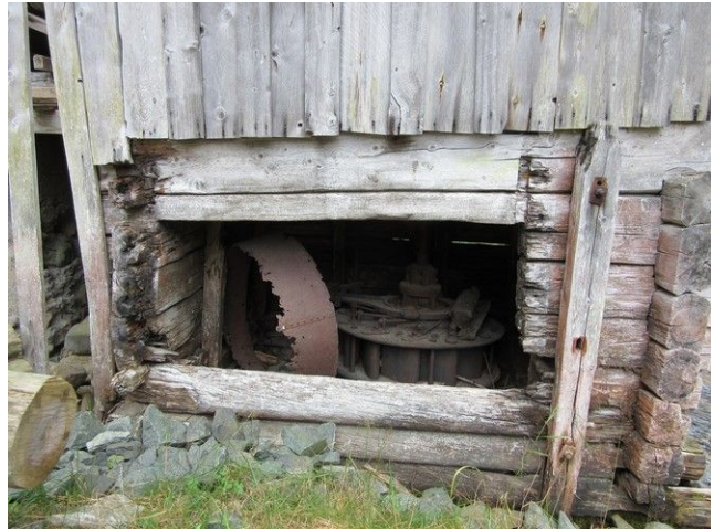
Myllyn konehuone rakennuksen luoteispäässä.
