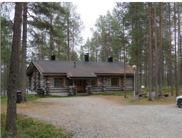
Kuva 5. Matkailualueen rakennuksia, itäinen alue.
