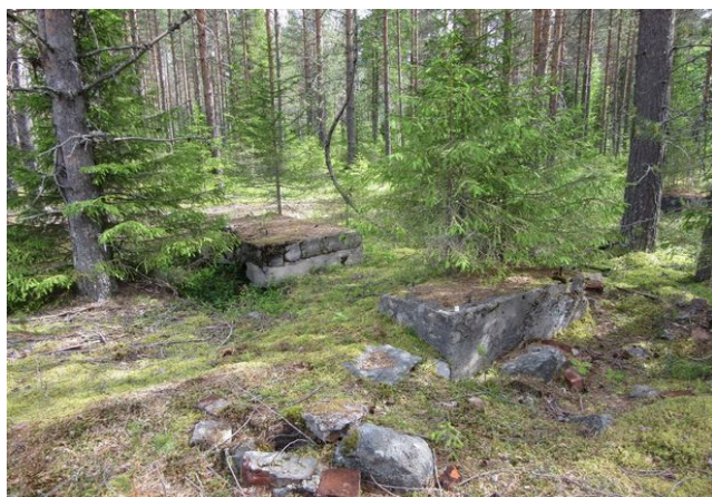
Rakenne 23, rakennuksen perustus koilliseen.
