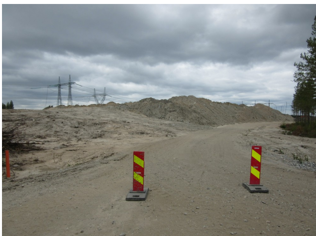
11. Pyhänselän sähköaseman ympäristössä on tehty massiivisia maansiirtoja.
