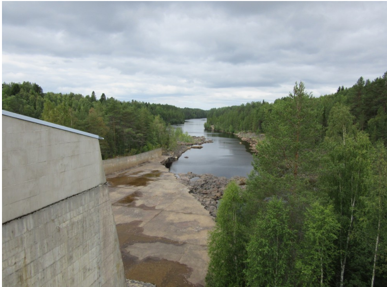
13. Pällin voimalaitoksen alakanavan pohja oli inventoinnin aikana näkyvillä. Kuva luoteeseen.
