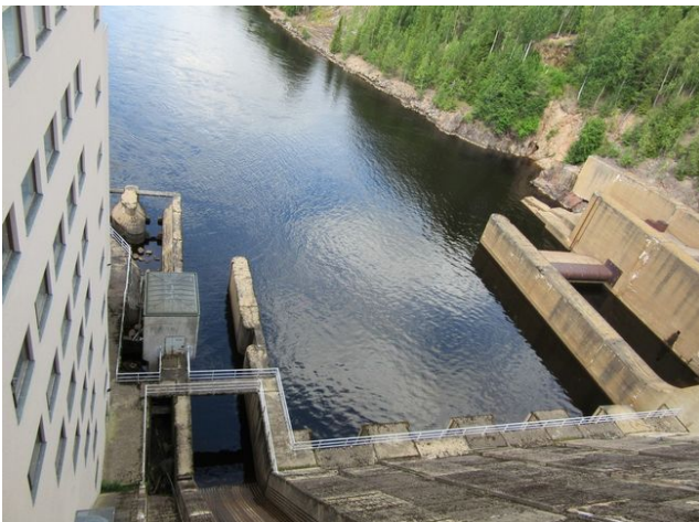
1. Pyhäkosken voimalaitoksen alakanavaa.
