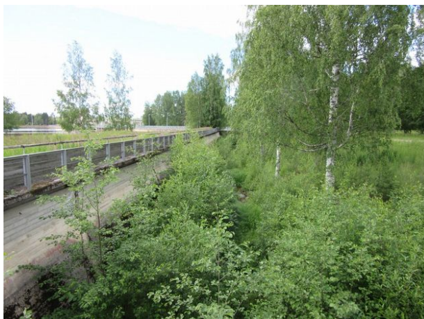
Kanavan eteläseinä Leppiniementien itäpuolella, kuva lounaaseen.
