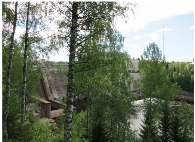
2. Pyhäkosken voimalaitos kuvattu kaakkoon.
