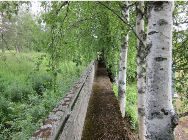
Kanavan eteläreunalla voi kulkea padon päällä Leppiniementien itäpuolella, kuva itään
