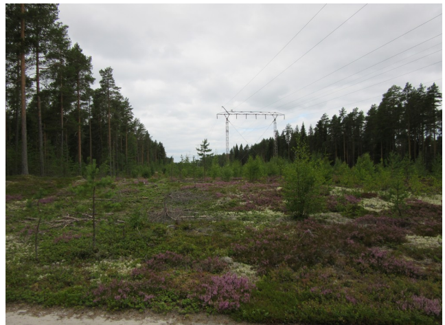
8. Hiekkadyynejä Pyhänselän sähköaseman ja kivitautisten asuinpaikkojen läheisyydessä, kuva länteen.
