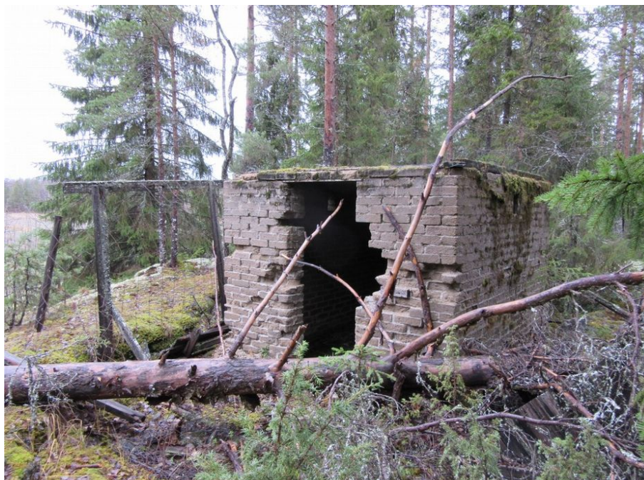
Muuntamon jäännös luoteeseen.
