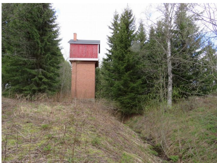
Rakentamatonta aluetta poiskäytöstä jääneen muuntamon ympäristössä alueen itäosassa, sen vieritse kulkee syvä oja. Kuva luoteeseen.
