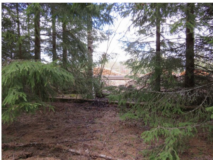
Rakennuksen betoniperustus radan varrella alueen itäosassa. Kuva pohjoiseen. Radan varrella on sijainnut useita rakennuksia, jotka on purettu.
