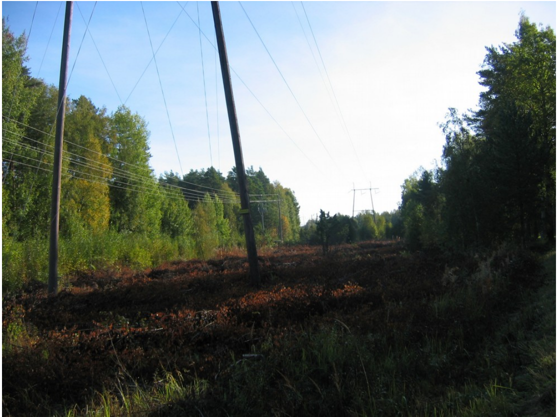
Kuva 5. Raivattua sähkölinjaa Kodisjoentien itäpuolella. Itään.
