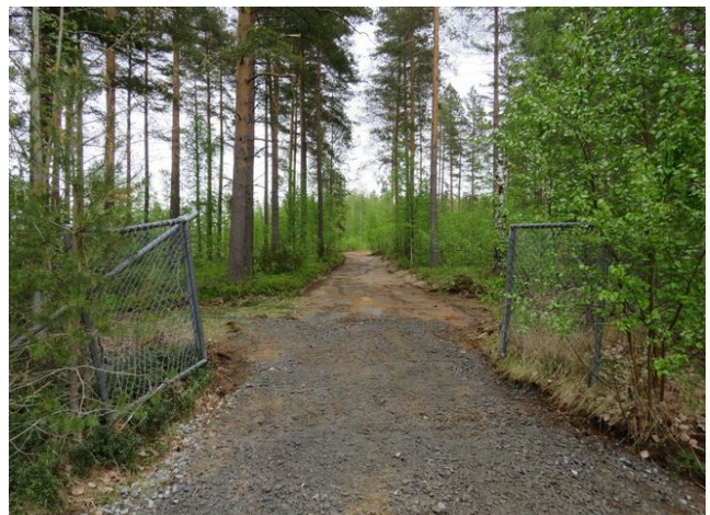
9. Kaivanto peitettynä, vedenottamon portilta itään.
