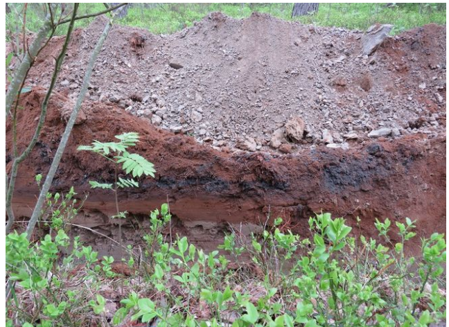
7. Vedenottamotien sepelikerroksia kaivannon seinämässä.
