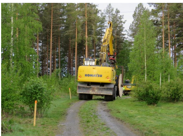
18. Kaivutyö suoritettiin kahdella kaivurilla.
