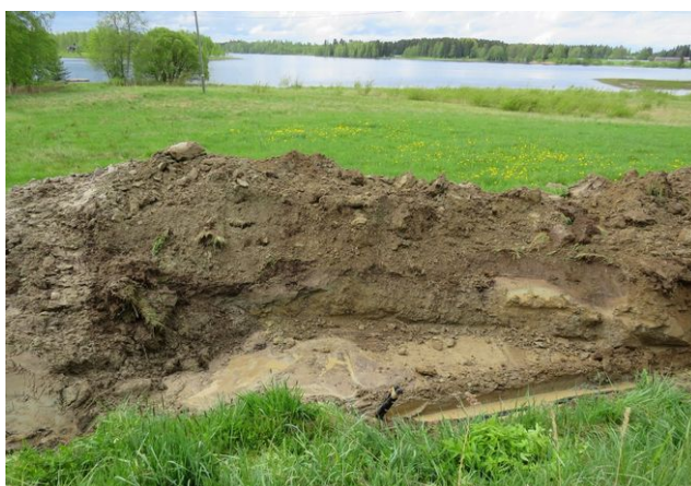
15. Kaivanto Hylkirannantien varrella n. 25 m peruskartalle merkitystä muistomerkestä pohjoiseen vuoden 1957 kaivausalueen lähellä. Maalaji on hiekkaa ja sa-vea.
