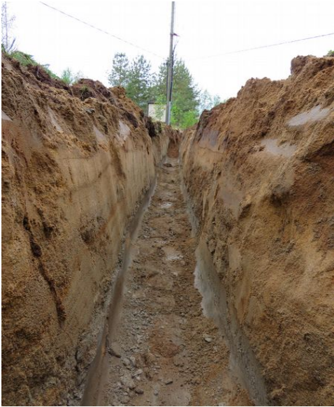
4. Kaapelikaivannon alkupää länteen.
