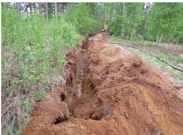
10. Kaivanto länteen asuinpaikan itäpuolella omakotitalon kohdalla. Kaivannossa ei havaittu arkeologisia kerrostumia.
