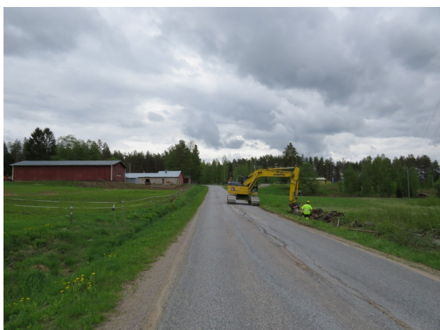
19. Kaivutyötä Hylkirannantien varrella, kuva etelään. Asuinpaikan ydinalue takana oikealla pelloilta kohoavalla mäellä.
