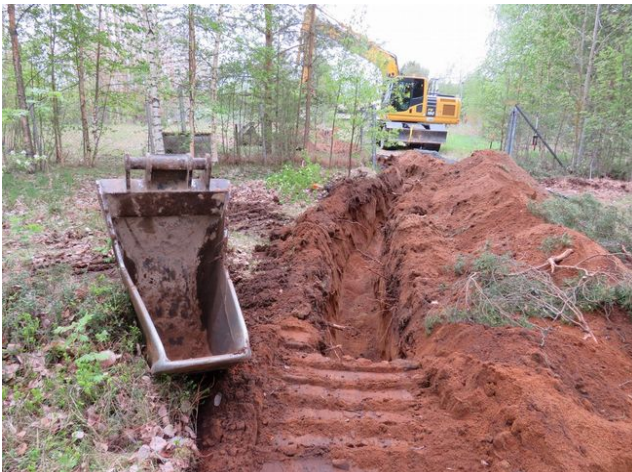
6. Kaivanto vedenottamon portin itäpuolella.
