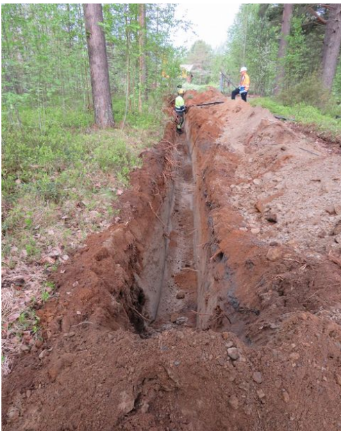
8. Kaivanto vedenottamon portin itäpuolella, länteen.
