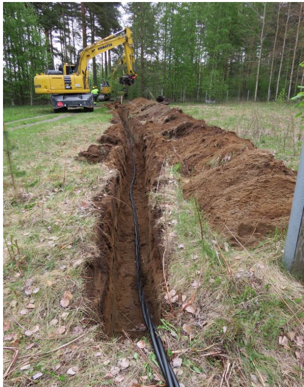
Vedenottamon aidatulla alueella kaivanto valmiina ja kaapeli upotettuna ojaan. Kuva itään.
