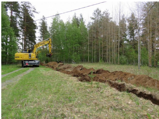
3. Yleiskuva vedenottamon alueelta itään.
