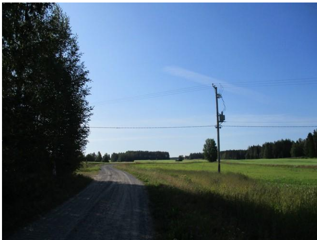
Kuva 1. Maakaapelilinjaus sijaitsee tien oikealla puolella. Kuvattu paikallistietä 18291.
