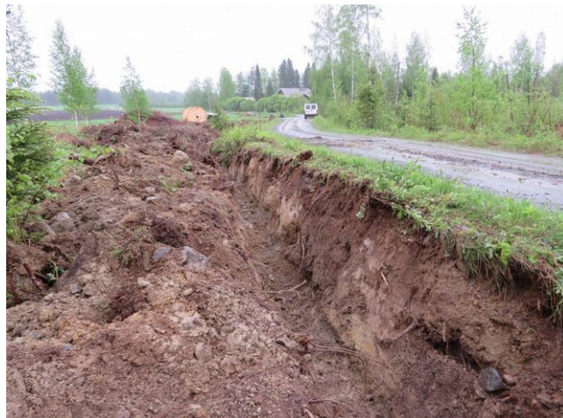
Kaapeliojan kaakkoispää kaivettuna.
