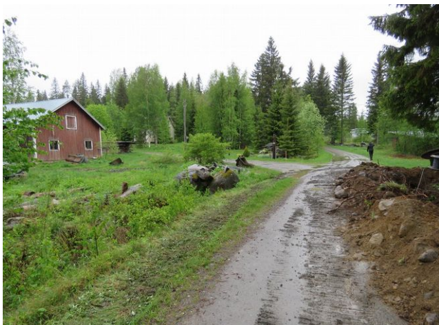
Kaapelilinja kaivettuna Kurun talon tiehaaraan.
