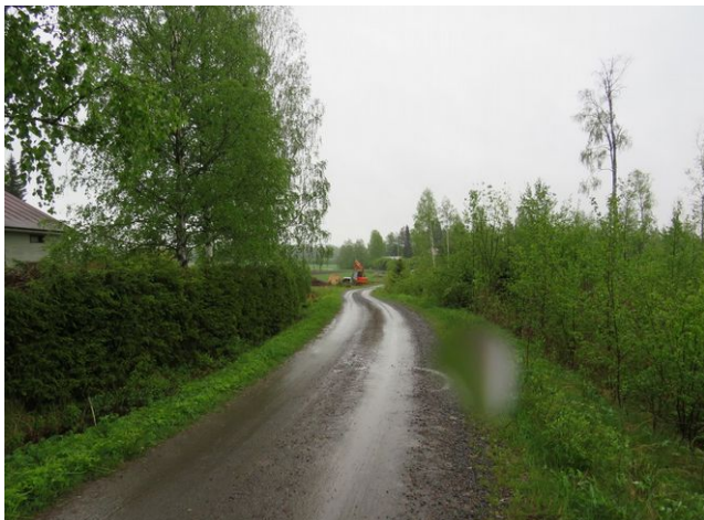
Kaapelilinjan kaakkoispää Kuruntien varrella ennen kaivuuta
