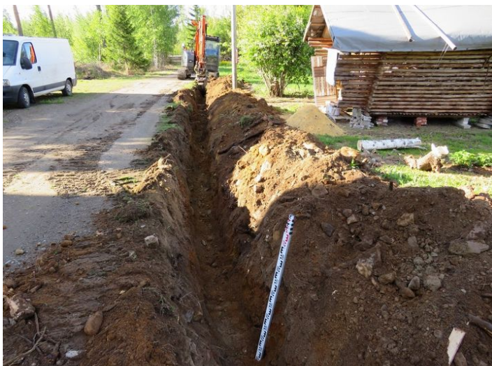
Piha-alueen osuus kaivettuna, kuva etelään.
