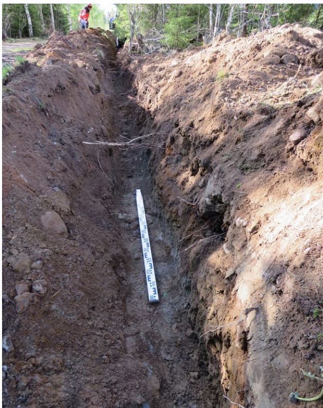
Kaapelikaivanto pellon kohdalla, kuva etelään.
