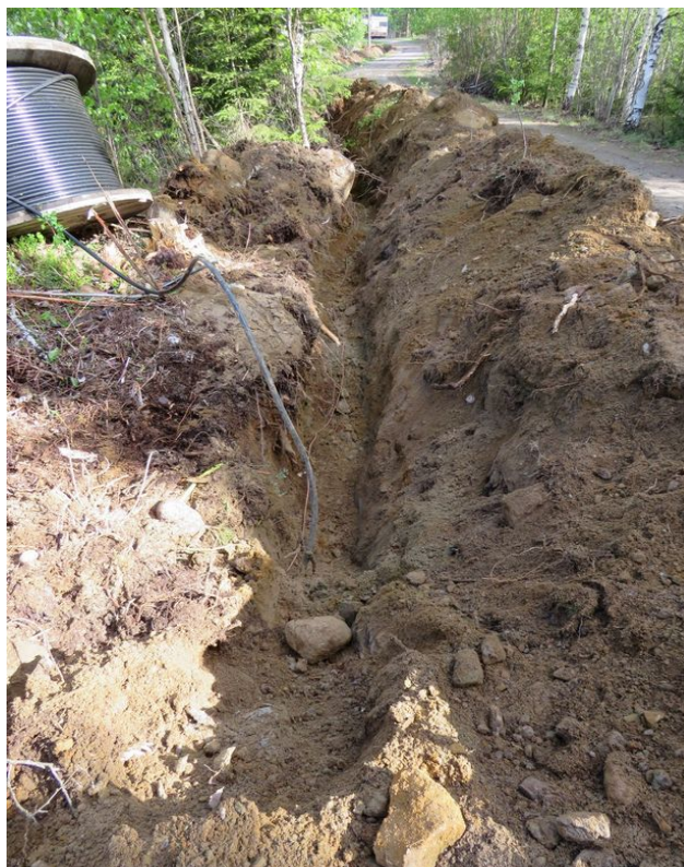
Kaivannon loppupää, kuva pohjoiseen.
