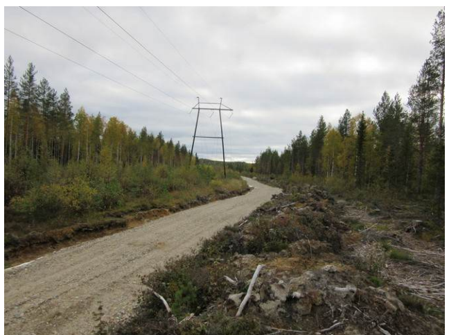
Kuva 14. Voimalinjan käytävä ja uusi tie mökille kuvattu lounaaseen.
