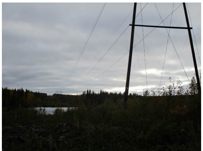
Kuva 12 Voimalinja ylittää järven Likolahden suussa, kuvattu lounaaseen.
