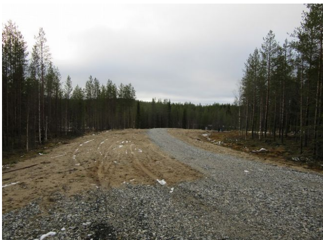
1. Länsireunalla kulkeva uusi tie pohjoiseen.
