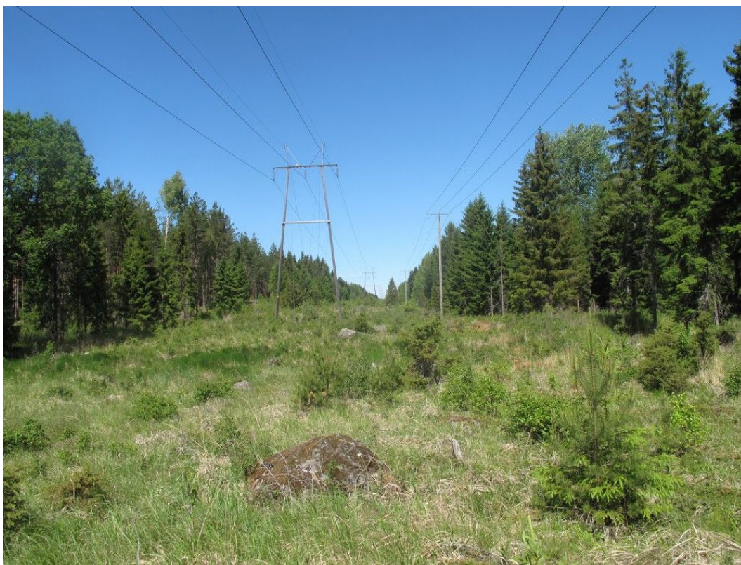
Kuva 3. Voimajohtolinjaa Rauman eteläpuolella. Pohjoisluoteeseen.
