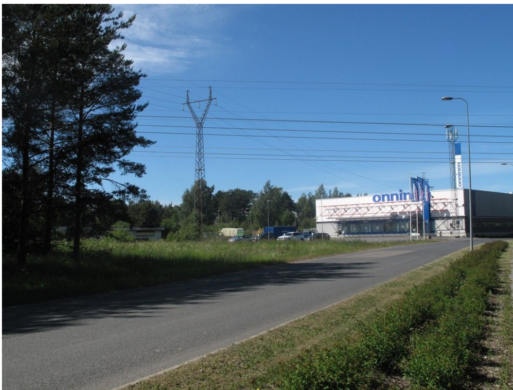
Kuva 2. Rakennettua linjanosaa voimajohtolinjan Rauman puoleisessa alkupäässä Lajon kaupunginosassa.
