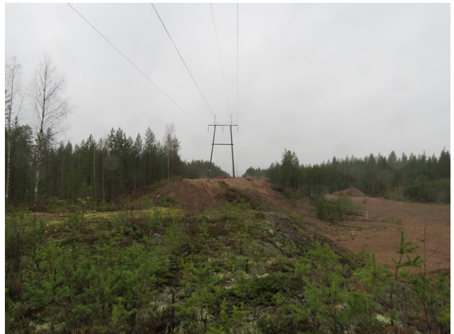
Kuva 16. Linjaus Linjaharjun sorakuopan kohdalla, kuvattu lounaaseen.
