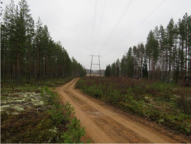
Voimalinjan käytävä rajatun mj-alueen pohjoislaidalla, kuvattu lounaaseen.
