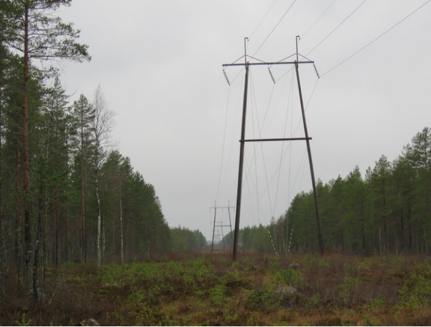
Kuva 13. 110 kV linjakäytävä Kanakaarrolla, kuvattu lounaaseen.
