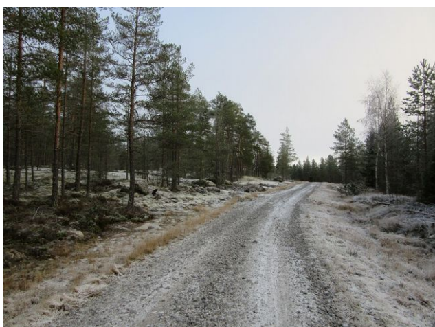
18. Väglinjen på projektområdets södra sida, foto mot sydost.
