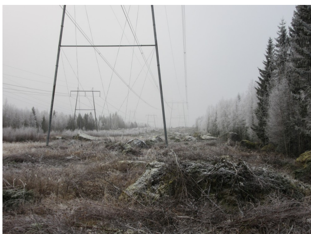
12. Omgivningen kring den planerade elstationen.
